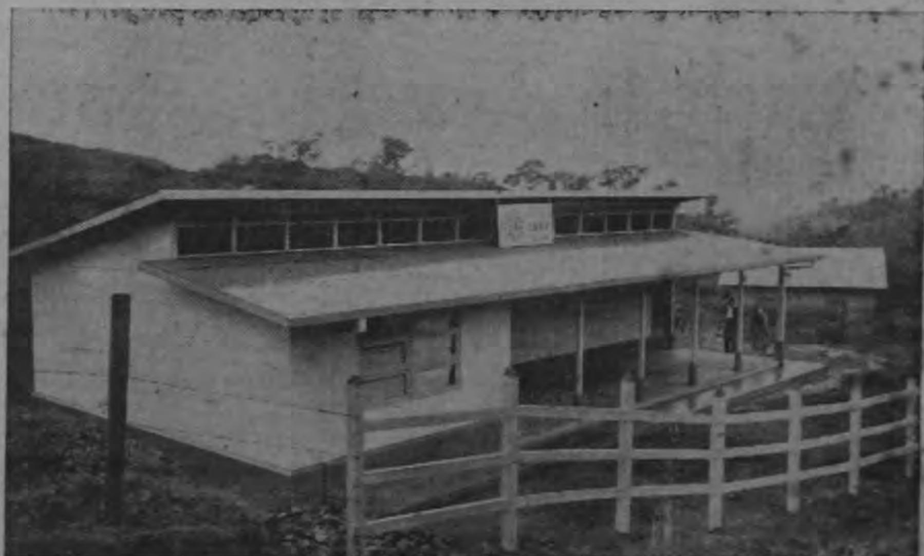
ESCUELA DE "BURIAL", Piedras Sur de San Ramón.— La presente gráfica corresponde al nuevo edificio escolar recientemente puesto en servicio en esa lejana población. El Ministerio de Obras Públicas, sin escatimar esfuerzos, llevó a cabo la realización de esta escuela que ha venido a llenar una necesidad sentida durante muchos años por los laboriosos habitantes de ese apartado rincón del país.
